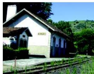
ESTAÇÃO DE ALVAÇÕES LINHA DO CORGO
