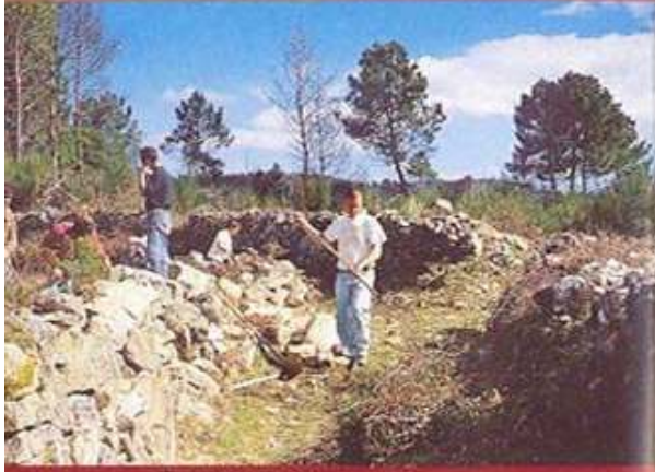
Trabalhos de recuperação
