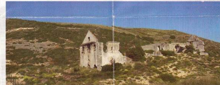
Ruínas do Convento de Penafirme
