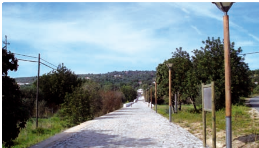
Ponte de Tôr Tôr Bridge
