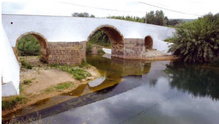
Ponte da Tôr Tôr Bridge
