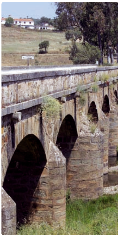
Ponte do Vascão Vascão Bridge
