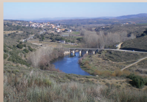
Ponte da Formigosa
